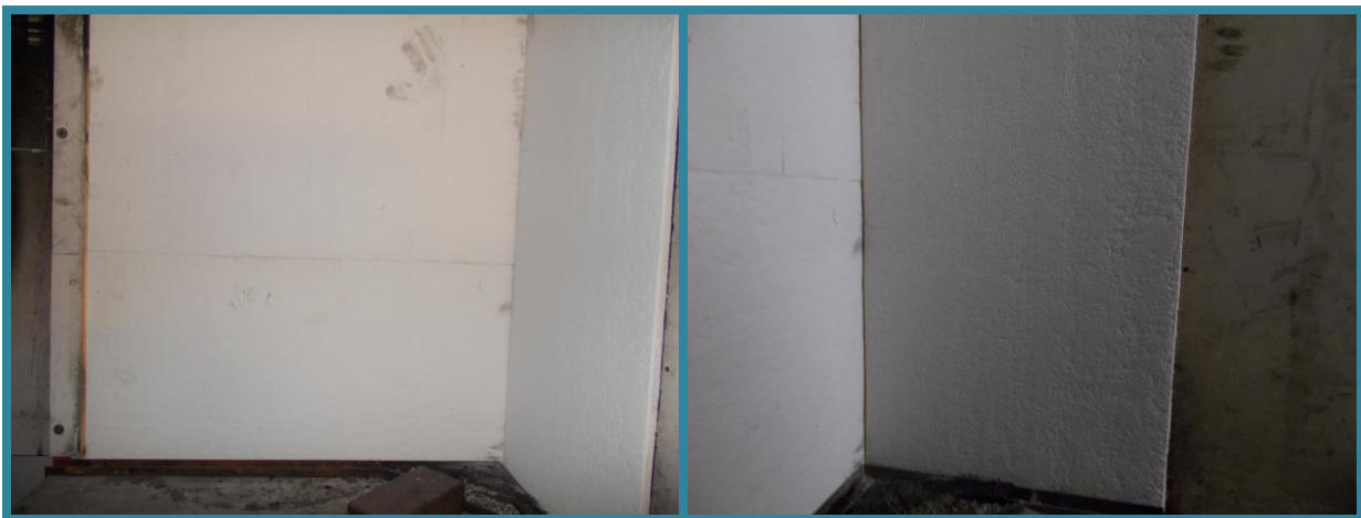
Fig.2 – Campione N. 2 – Primo piano dei pannelli, lato lungo e lato corto a un'altezza di 500 mm dal pavimento del carrello
